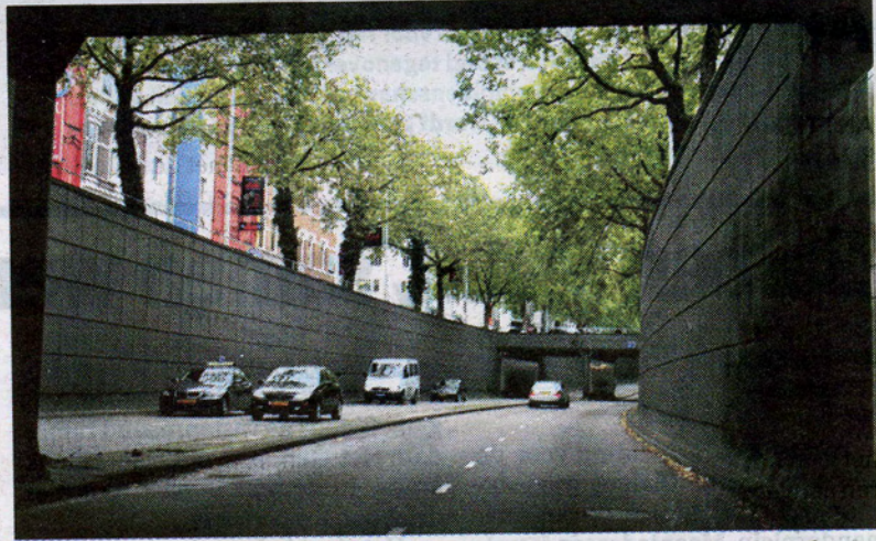
De tunnel van de 's-Gravendijkwal wordt deels overkapt en verlengd richting Middellandstraat. FOTO SANNE DONDRS
